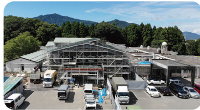
建設風景 右側、旧施設
